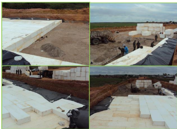
Figura 2. Metodologia executiva do aterro leve com EPS.
