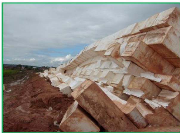
Figura 4. Aterro 3 rompido.
