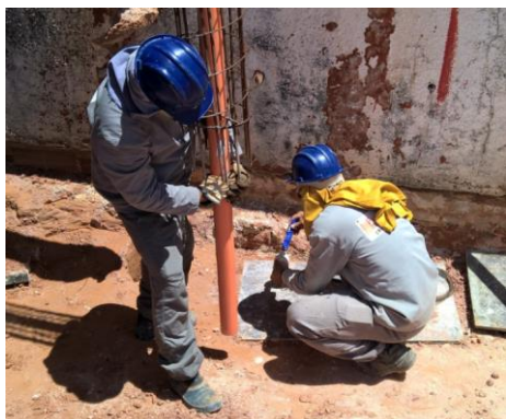
Figura 3. Instalação do Tubo Guia na Armadura.
