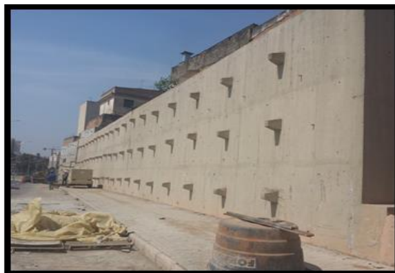
Figura 2: Obra ancorada realizada em Congonhas-MG.
