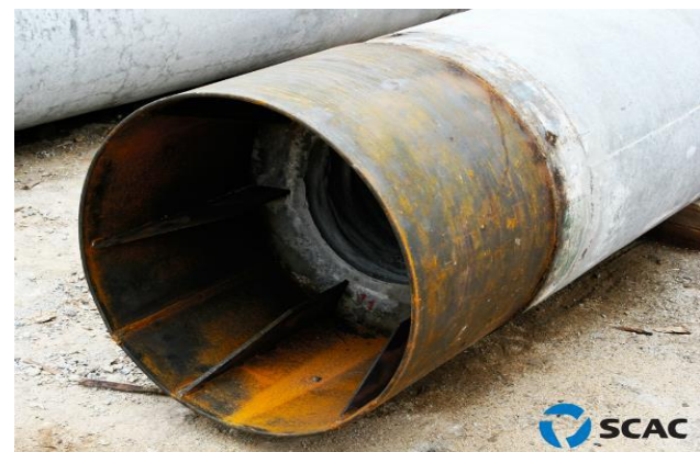
Figura 4. Estaca pré-moldada com ponteira de aço (SCAC, 2014).
