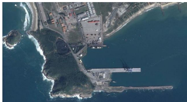
Figura 2. Fotos do porto antes e após a conclusão da obra.
