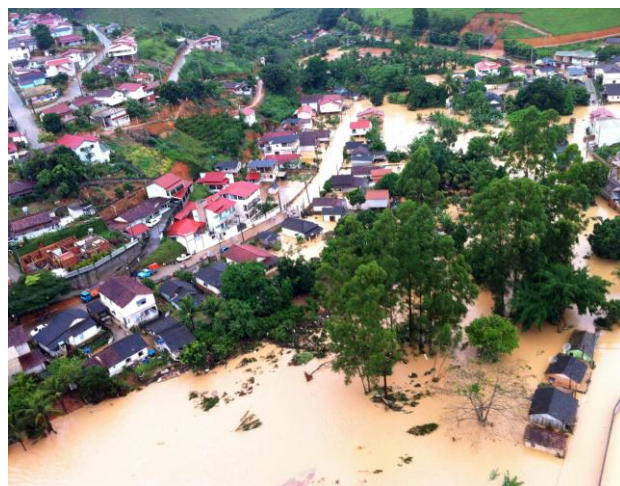
Foto: Defesa Civil ES (17/12/2013)
