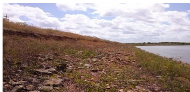
Figura 3. Barragem Premuoca, vista do talude de montante. (Fonte: Gomes, 2016)
