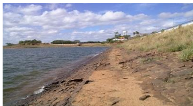
Figura 2. Barragem Forquilha, vista do talude de montante. (Fonte: Gomes, 2016)
