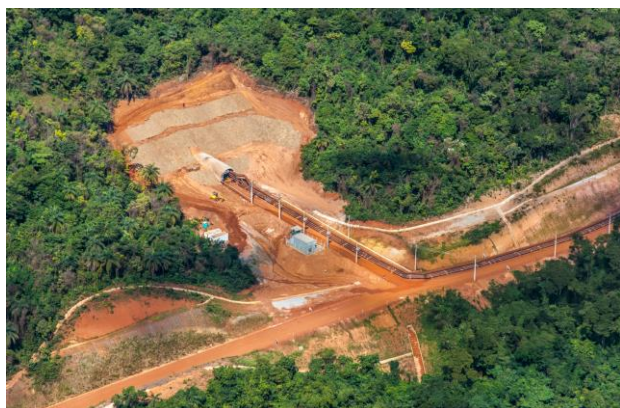
Figura 1: Túnel Laranjeiras. Fonte: Arquivo Vale.
