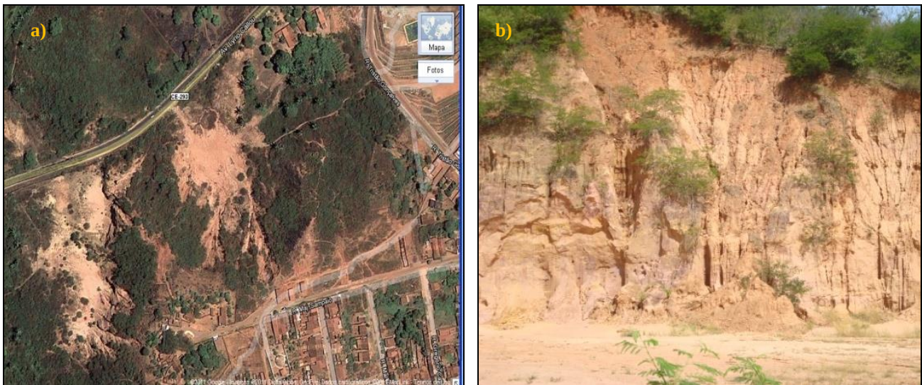
Figura 2. a) Vista Aérea da Encosta Erodida; b) Detalhe da Vista Frontal da Encosta Estudada Fonte: Adaptado de Google Earth (2016) e Foto UFCA.
