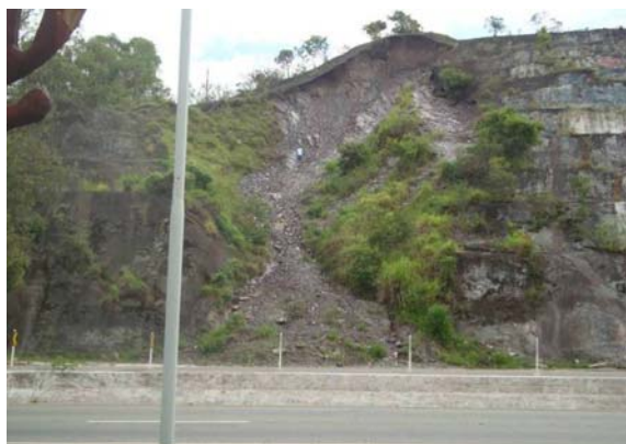
Figura 5. Vista do Talude Ponteio em 2010
