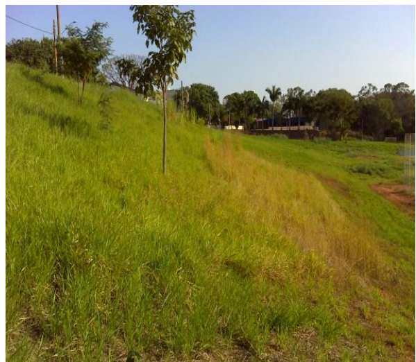
Figura 3. Talude 2 – Ginásio Poliesportivo. Sanches (2015).
