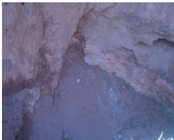
Figura 5. Plano de fraqueza e de percolação preferencial de fluidos derivado da xistosidade da rocha matriz (vista interior de uma trinca).
