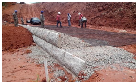
Figura 1. Estrutura de contenção em execução.
