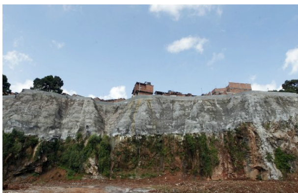
Figura 10. Situação após intervenção. Fonte: http://www.secom.ba.gov.br .
