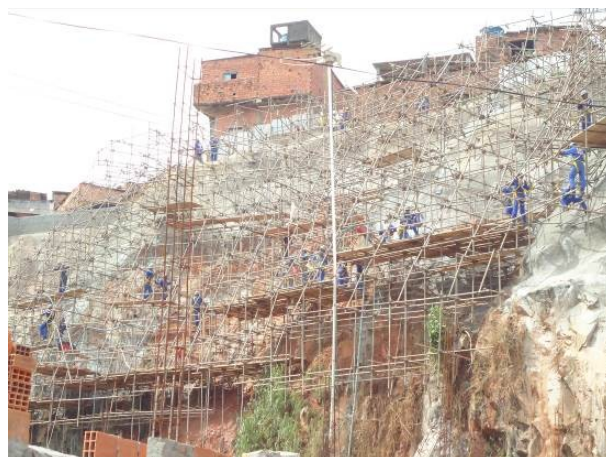
Figura 9. Ancoragem dos andaimes e diversas frentes de trabalho. Fonte: Elaborado pelos autores (2016).
