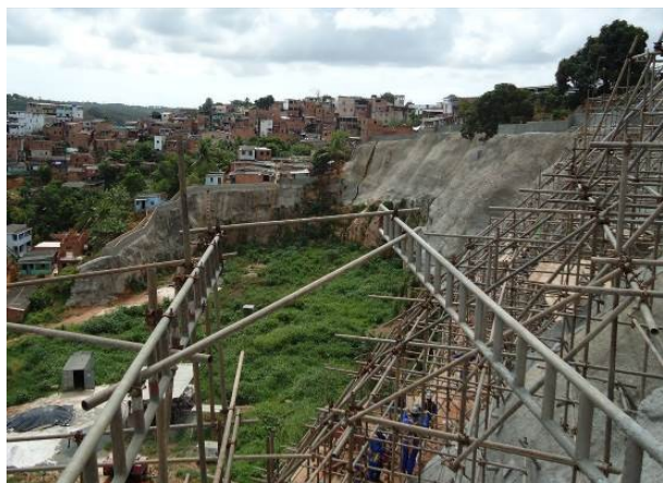
Figura 8. Andaimos e sua estrutura auxiliar. Fonte: Elaborado pelos autores (2016).
