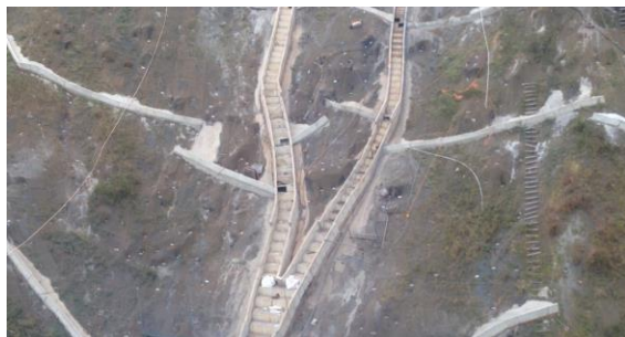
Figura 8: Trecho executado das DAD's
