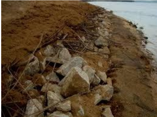
Figura 5. Enrocamento vegetado realizado em obra nas margens do Rio São Francisco (Araújo-Filho et al, 2013).
