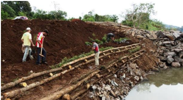
Figura 6. Parede Krainer executada nas margens do Rio Taquari, em Estrela - RS (Prefeitura Municipal de Estrela, 2010).
