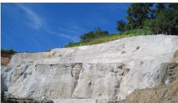
Figura 6. Revestimento da face com concreto projetado e fibras metálicas (Seabra, 2015).
