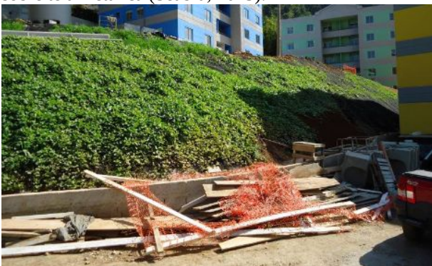
Figura 5. Revestimento da face com tela metálica e biomanta (Maccaferri, 2011).
