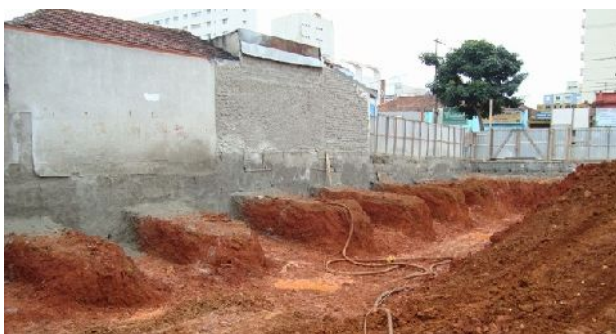
Figura 1. Escavação em bermas (Seabra, 2015).
