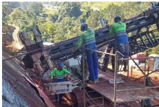
Figura 2. Perfuração e instalação do grampo para posterior injeção: Duplicação da Serra do Cafezal, Rodovia Regis Bittencourt, km 353 (Seabra, 2015).
