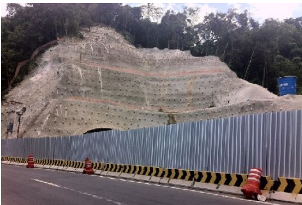
Figura 4. Revestimento da face em concreto projetado sobre tela metálica (Seabra, 2015).
