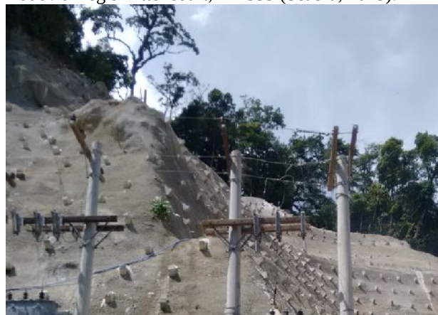
Figura 3. Revestimento: Concreto projetado sobre tela metálica. Desemboque do novo túnel da nova subida de Petrópolis (Seabra, 2015)
