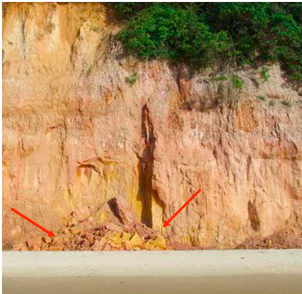
Figura 1. Evidências de erosão nas falésias, com deslocamento causado por solapamento e posterior deposição de sedimentos em sua base, na praia da Baía dos Golfinhos - Pipa/RN (Piérri, 2008).
