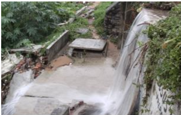
Figura 8. Muro de contenção localizado 5 metros abaixo da Rua Guanabara (Santos jr. et al., 2016).
