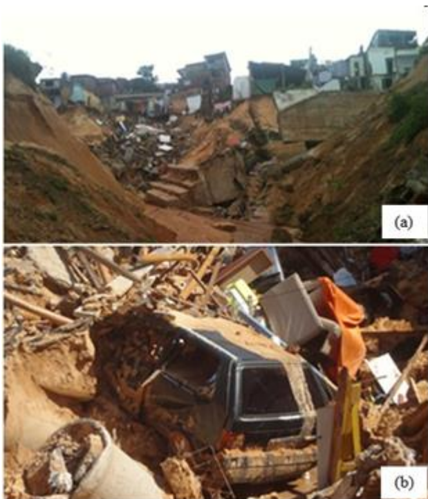
Figura 13. (a) Muro de arrimo tombado; (b) Detritos transportados pelo fluxo.
