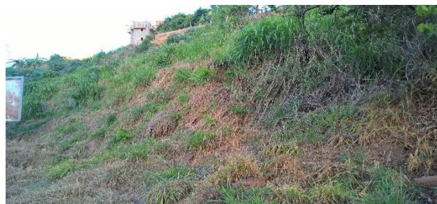
Figura 1. Talude com a face parcialmente coberta por vegetação.
