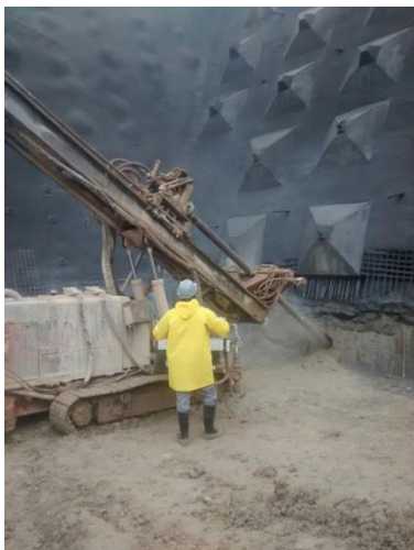
Figura 3. Processo de Perfuração do Solo para a Instalação do Tirante.
