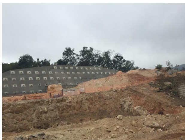
Figura 2. Contenção executada em uma Encosta no Trecho Norte do Rodoanel Mário Covas.
