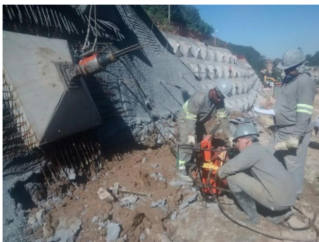
Figura 4. Processo de Protensão do Tirante.
