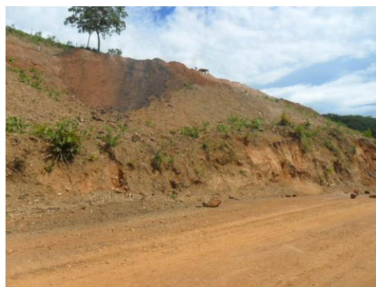
Figura 2. Vista do talude do Corte 108.
