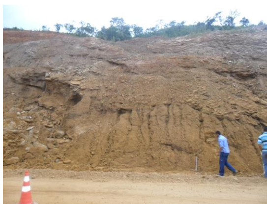
Figura 11. Vista geral da área do Corte 127.
