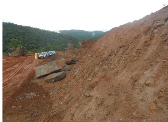
Figura 4. Vista do talude do Corte 111.
