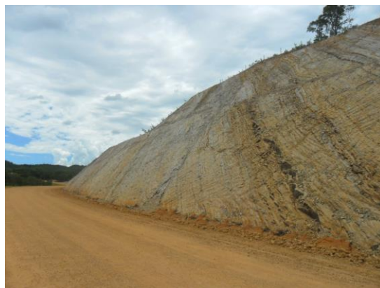
Figura 10. Vista geral da área do Corte 126.
