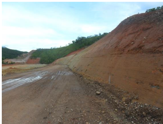
Figura 5. Vista do talude do Corte 112.
