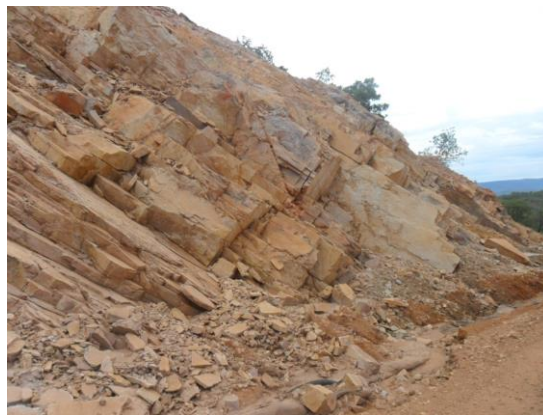
Figura 9. Vista geral da área do Corte 120.
