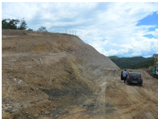
Figura 6. Vista do talude do Corte 114.
