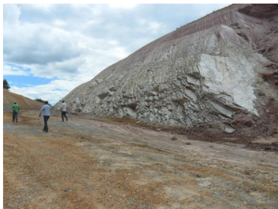
Figura 8. Vista do talude do Corte 119.
