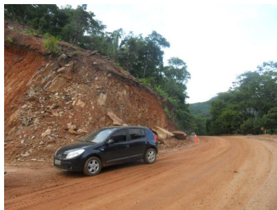
Figura 3. Vista do talude do Corte 110.
