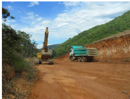
Figura 1. Vista do talude do Corte 107.
