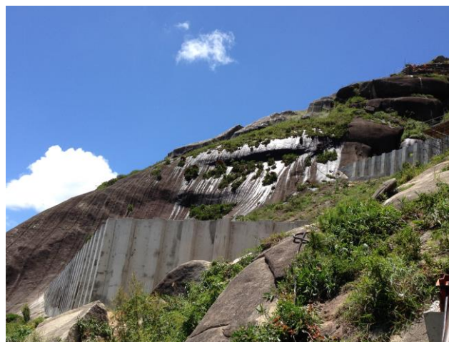
Figura 8. Estruturas de contenção convencionais
