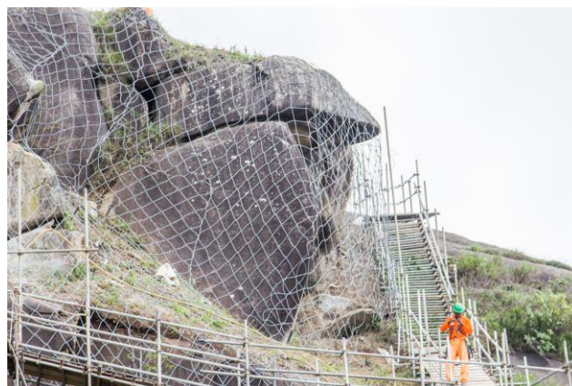
Figura 7. Detalhe dos painéis de alta resistência HEA para estabilização dos blocos.
