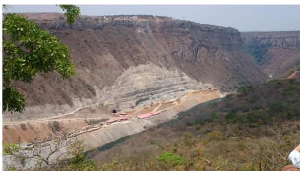
Figura 1. Vista das escavações, a partir da margem esquerda
