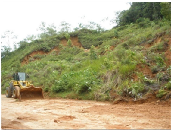
Figura 8 – Ruptura “normal” no 2º segmento do talude. Fonte: ENGEMIN (2011).
