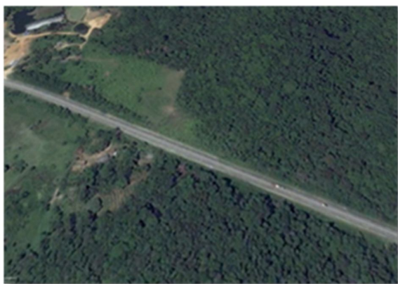
Figura 5 – Vista aérea da encosta antes dos escorregamentos.
