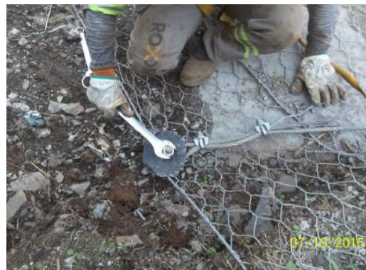
Figura 20. Instalação do cabo de aço de sustentação das telas na crista do talude.
