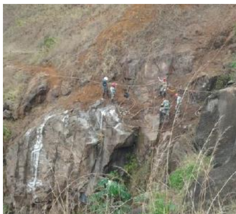
Figura 9. Atividades sendo realizadas com a técnica a rapel e com o uso de uma linha de vida ancorada em rocha.
