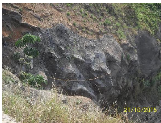
Figura 22. Tela aplicada após a finalização dos tratamentos de estabilização do maciço rochoso. Vista da parte superior.
