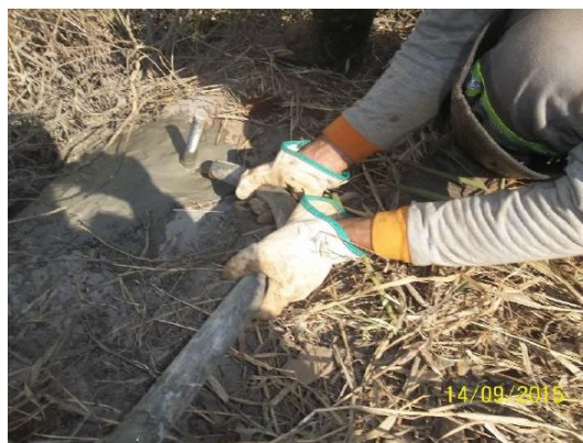
Figura 13. Injeção de calda de cimento com relação água-cimento igual 0,5.
