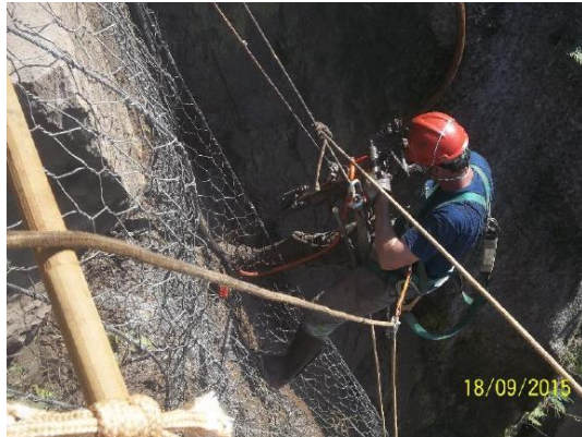
Figura 15. Perforação da malha de grampos com técnica de rapel.
