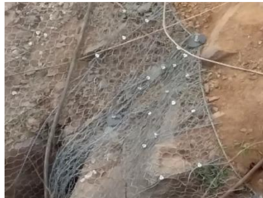
Figura 19. Detalhe do processo construtivo realizado de acordo com o projeto. Amarração na borda superior. Sobreposição da tela para a conexão Alpha.
