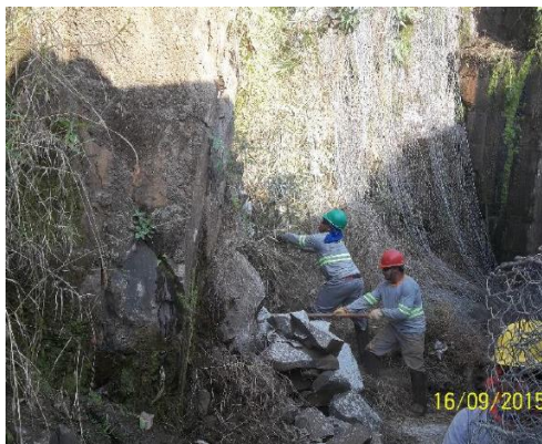
Figura 11. Abatimento manual de blocos e fragmentos de rocha soltos ("bate-choco").
