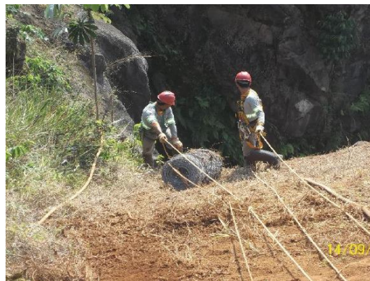
Figura 12. Transporte do material até a frente de trabalho com técnica de rapel e tirolesa.
