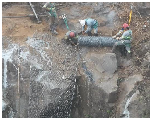
Figura 14. Processo de fixação na borda superior da tela e lançamento sobre o talude.
