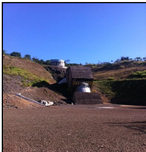
Figura 1. Vista Geral da PCH Jataí.
