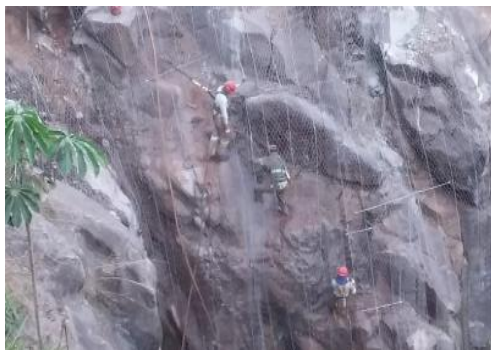
Figura 16. Perforação, injeção de calda e instalação de grampos na malha sobre o talude.
