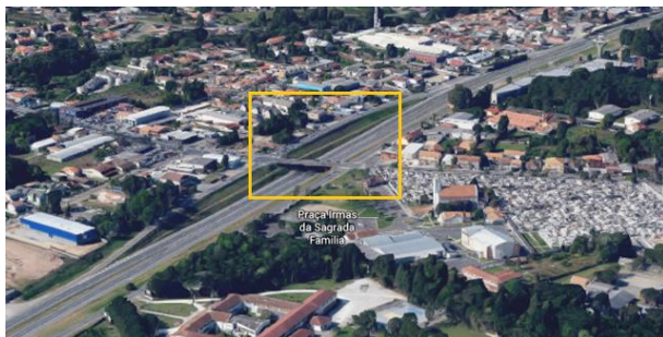
Figura 3. Vista aérea do talude.
