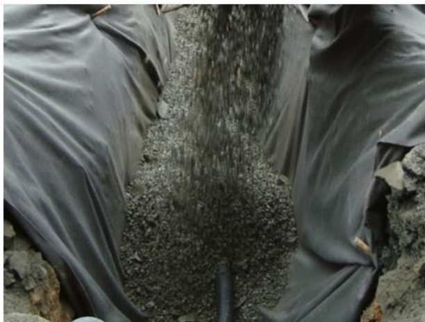
Figura 8. Detalhe da instalação do tubo de drenagem.
