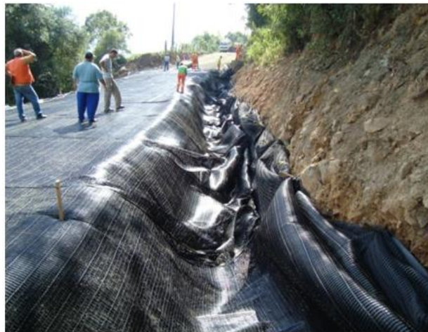
Figura 9. Ancoragem da geogrelha no dreno longitudinal.
