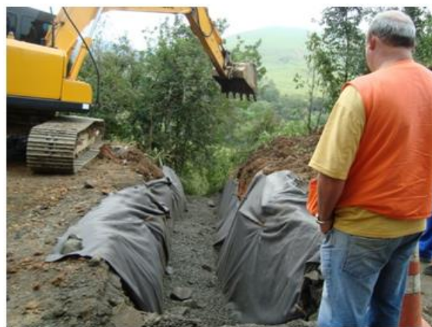
Figura 7. Construção de dreno transversal.
