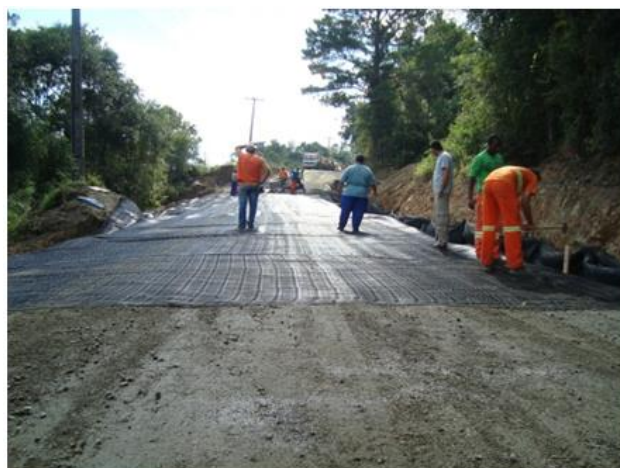
Figura 10. Detalhe da geogrelha bem esticada.
