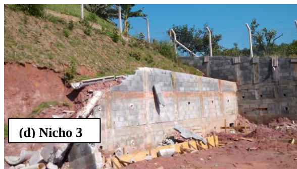
Figura 3. (a) Nicho 1 Muro com presença de trinca, (b/c) Nicho 2 escorregamento e tombamento do muro, (d) Nicho 3 presença de trincas e fissuras com indícios de cunha de ruptura.
