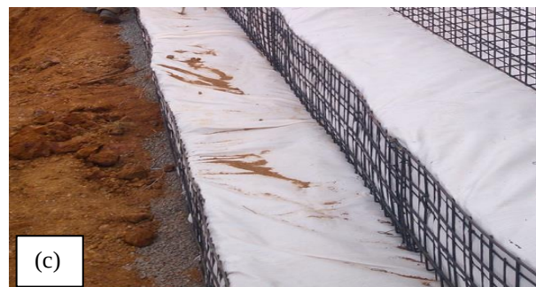
Figura 11: (a) escavação da saia do aterro sem compactação (b) compactação da base para StrataSlope utilizando solo local. (c) envelopamento de solo com geotêxtil tecido faceado com StrataSlope .
