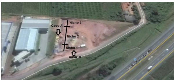
Figura 1. Imagens da área de estudo por satélite indicando vista geral da obra com os escorregamentos e as patologias local.
