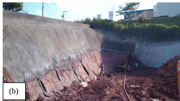
Figura 9: (a) Demolição muro de divisa em alvenaria (b) estabilização através de solo grampeado e projetado.
