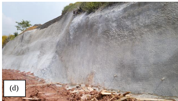
Figura 12: (a) vista geral muro lateral, (b) vista superior geral muro frontal (c) crista de aterro compactada com sistema StrataSlope impermeabilizada com calda de cimento (d) vista geral muro frontal.
