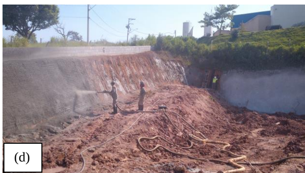
Figura 8: (a) Perfuração descendente sobre aterro, (b) Vista geral da berma com material do escorregamento, (c) controle através da pressão de injeção, (d) aplicação de concreto projetado.
