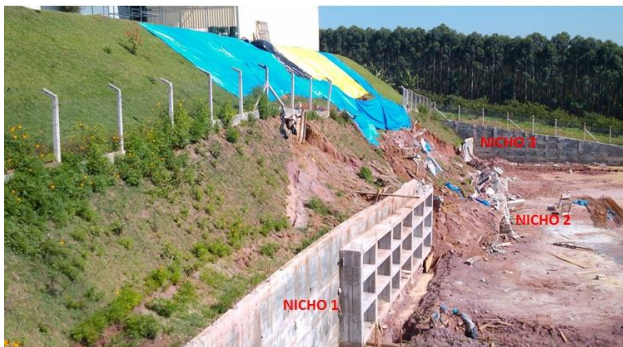
Figura 2: Vista geral do Caso A, dividido em nichos para avaliação do sistema de recomposição.
