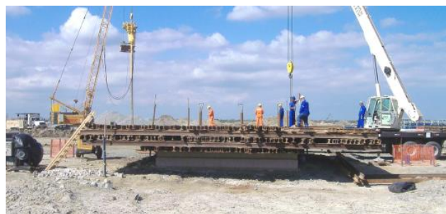
Figura 3. Área teste com carregamento com trilhos. (TKCSA, 2007).
