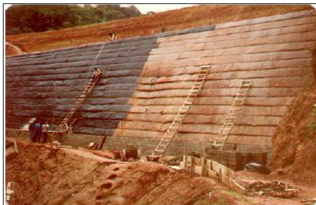
Figura 2. Estrutura de solo reforçado construída em 1984 na SP-123 (Patias, 2005).
