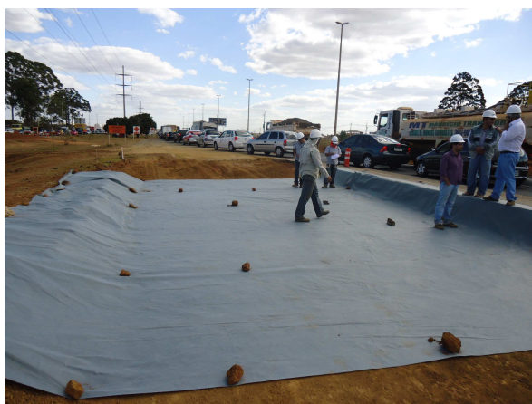
Figura 9 – Aplicação do Geotêxtil.
