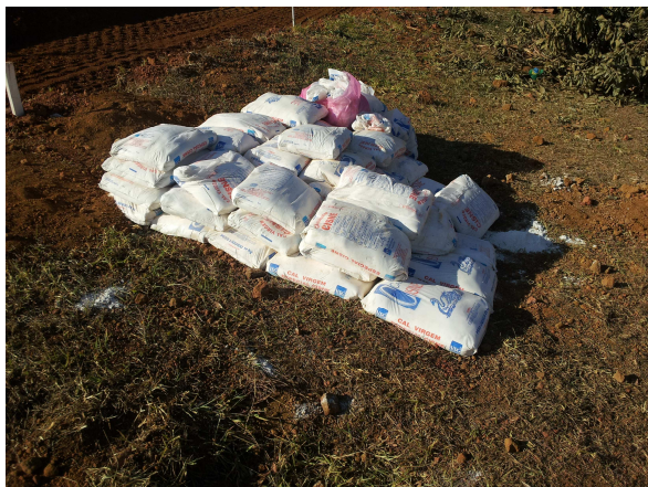
Figura 13 – Aplicação da cal.
