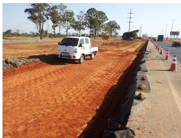
Figura 11 – Aplicação da Geogrelha.
