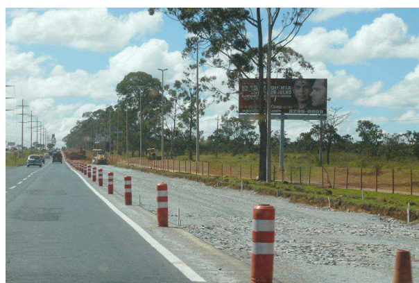
Figura 5. Seção tipo da camada de Rachão.
