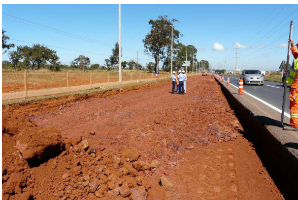
Figura 7 – Aplicação do cascalho Laterítico.
