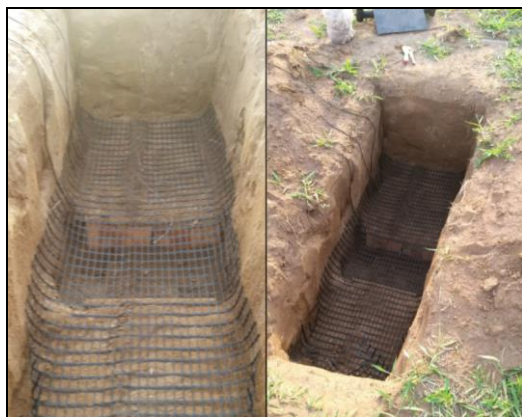
Figura 4. Vala escavada com a geogrelha.
