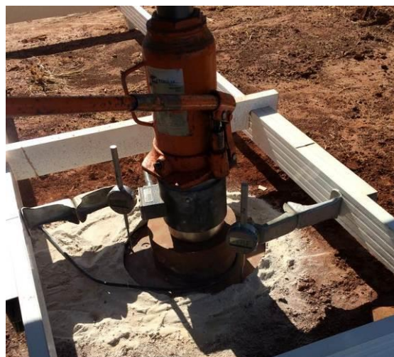
Figura 9. Ruptura do Solo.
