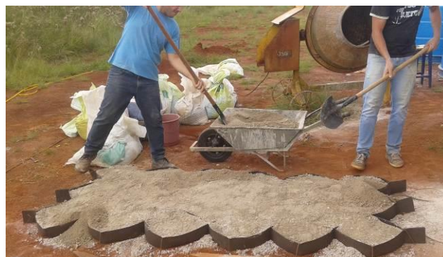
Figura 4. Preenchimento da geocélula.
