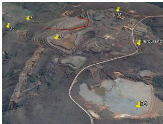
Figura 5 - Mina onde houve o rompimento (SUPERINTENDÊNCIA REGIONAL DE REGULARIZAÇÃO AMBIENTAL CENTRAL METROPOLITANA, 2014)
