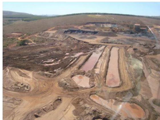
Figura 4 - Vista da superfície de ruptura (SEÇÃO DE SEGURANÇA E SAÚDE DO TRABALHADOR, 2014)
