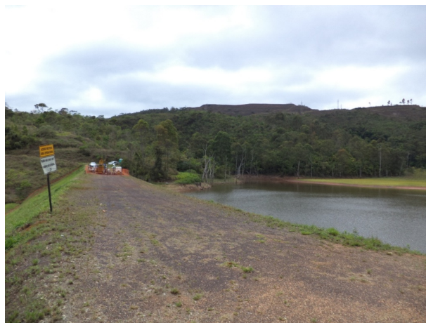
Figura 3. Foto da Barragem do Galego em 2014.
