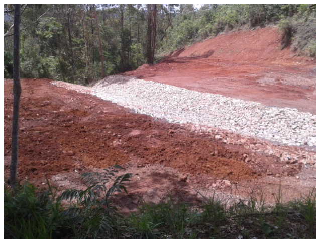
Figura 7. Canal do Dique 11 protegido com enrocamento.
