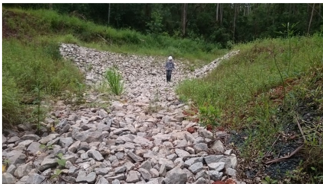
Figura 17. Canal de drenagem no antigo reservatório do Dique 12.
