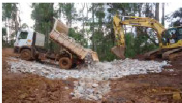
Figura 12. Lançamento do enrocamento no canal do Dique 13.
