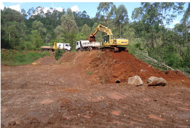
Figura 5. Escavação no reservatório do Dique 11.
