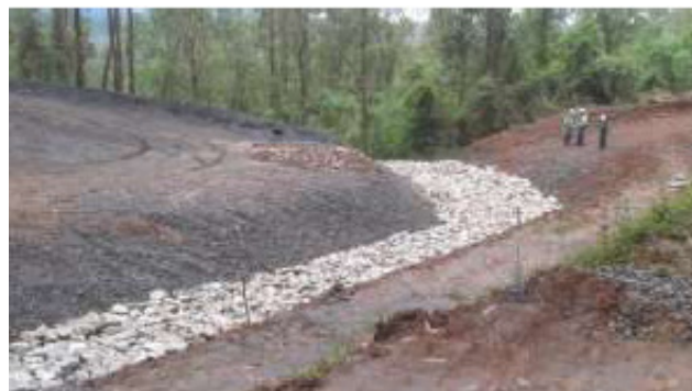
Figura 10. Canal do Dique 13 finalizado.
