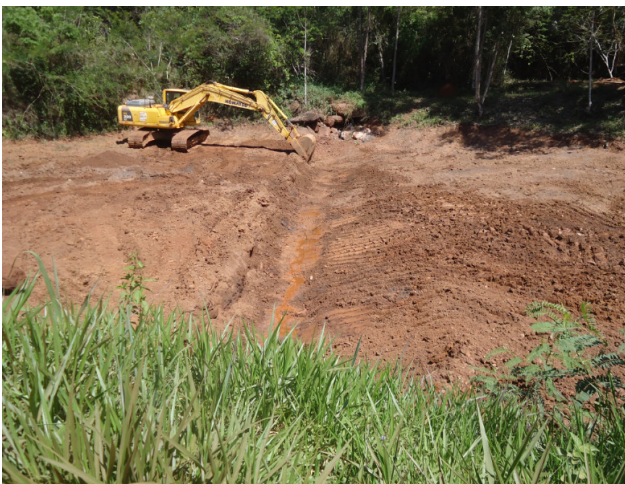
Figura 6. Escavação do canal no Dique 11.
