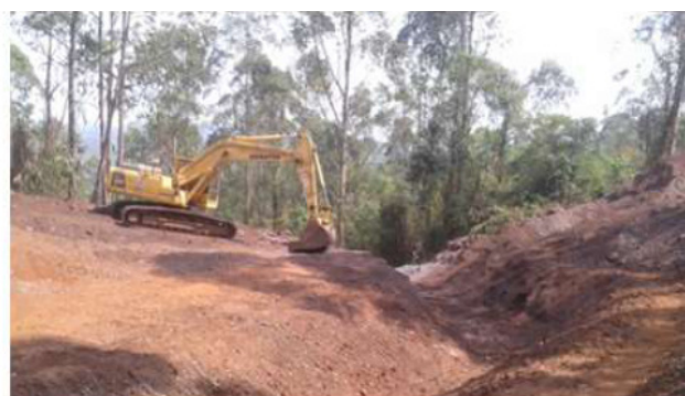
Figura 8. Escavação do canal no Dique 12.
