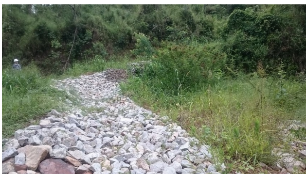
Figura 18. Canal de drenagem no antigo reservatório do Dique 13.
