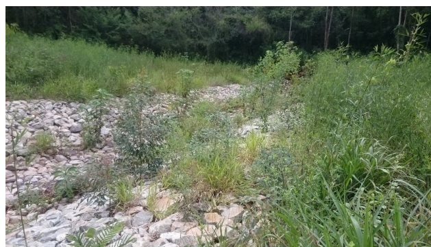
Figura 15. Canal de drenagem no antigo reservatório do Dique 11.
