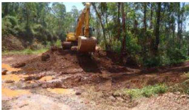
Figura 11. Escavação no reservatório do Dique 13.
