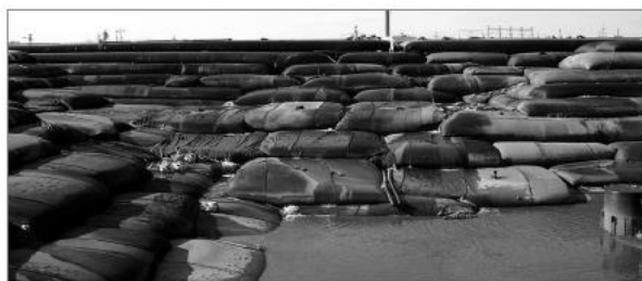
Figura 1. Empilhamento de Tubos têxtil em Salt Lake City (2009) – Maccaferri.
