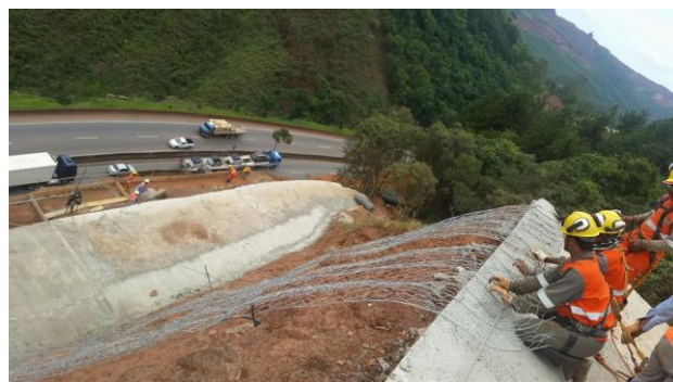
Figura 5: Aplicação de tela hexagonal de dupla torção associada à cabos de aço para proteção de talude rochoso.
