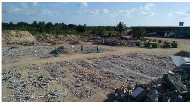
Figura 2. Detalhe de etapa de triagem manual dos resíduos.
