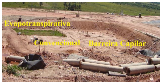
Figura 3. Esquema da disposição das células experimentais.
