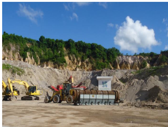
Figura 1. Pátio da usina de beneficiamento de RCD-R.
