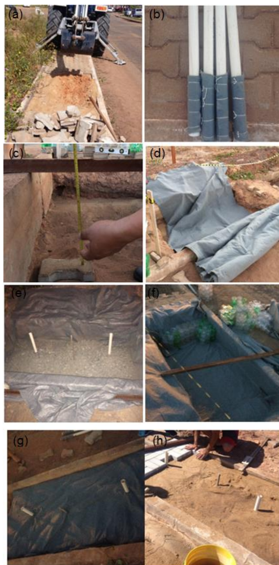
Figura 5. Sequência de montagem das estruturas: (a) escavação; (b) execução dos piezômetros de Casagrande; (c) nivelamento; (d) posicionamento da manta; (e) posicionamento da instrumentação; (f) enchimento com garrafas PET; (g) envelopamento e (h) assentamento dos blocos de concreto permeáveis.
