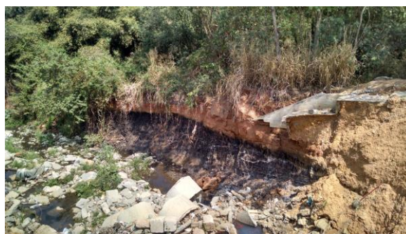
Figura 1. Perfil dos Solos Encontrados na Erosão.
