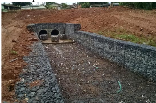
Figura 5. Canal Antes de Receber o Argamassamento.
