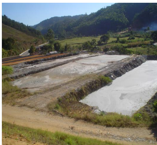
Figura 1. Tanques de rejeitos da extração de rochas ornamentais.
