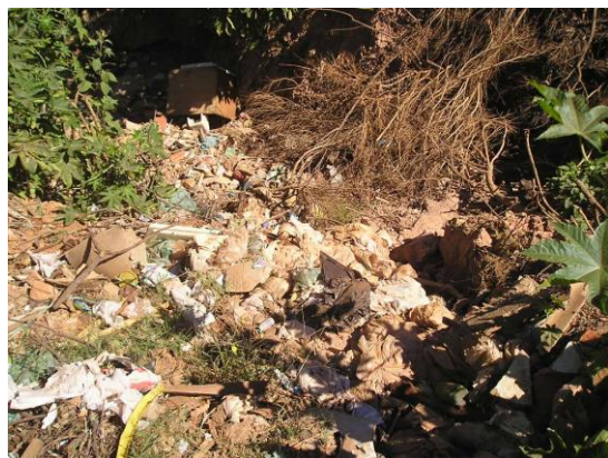
Figura 3. Área do início do processo erosivo.
