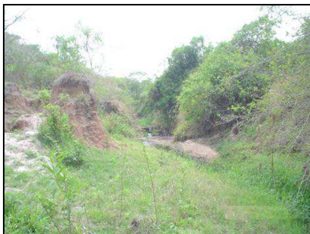
Figura 5 – Erosão remontante no canal do ribeirão Monte Serrat, com taludes já sendo erodidos. Fonte: Acervo TBG (2011).
