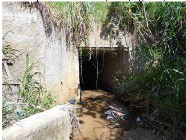
Figura 9 – Imagem da galeria pluvial a 400 m a jusante seção de estudo no riacho Jardim Novo Maracanã. Fonte: Acervo TBG (2015).
