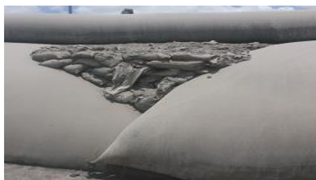
Figura 9 – Preenchimento dos vazios entre geoformas.
