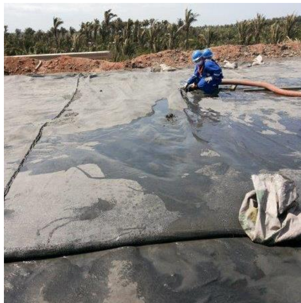
Figura 4 – Teste em campo do preenchimento das geoformas.
