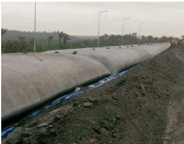
Figura 7 – Primeira Fase: camada inferior de geoformas.
