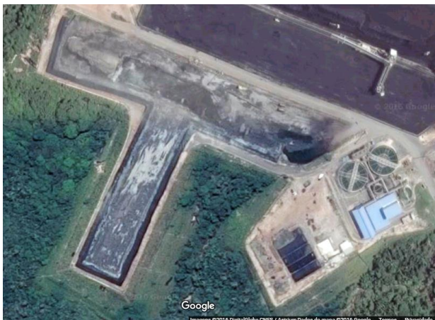
Figura 11 – Vista da área da célula de disposição de cinzas. Fonte: Google Maps. Acesso em 15/03/2016.
