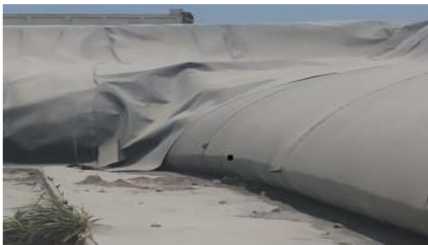
Figura 10 – Posicionamento da geomembrana sobre o dique.
