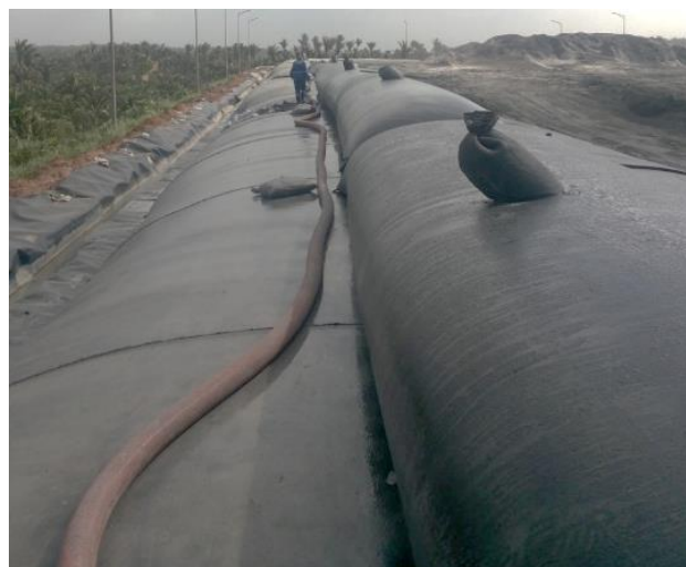
Figura 8 – Segunda Fase: camadas inferior e superior de geoformas.
