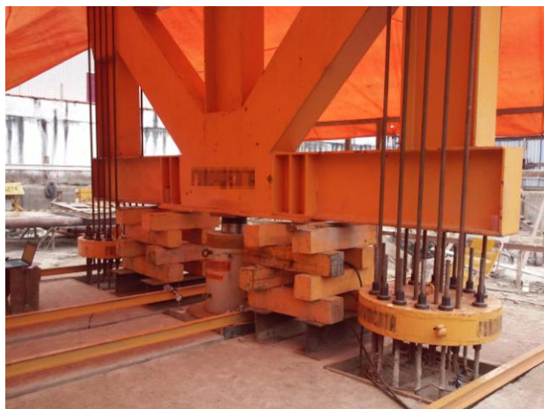
Figura 3. Execução da prova de carga.
