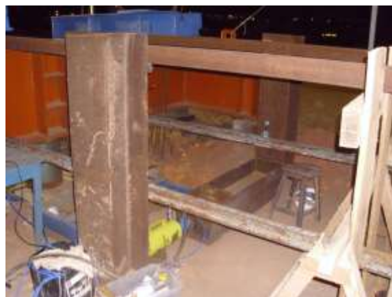
Figura 7. Montagem de uma prova de carga horizontal em estacas metálicas.
