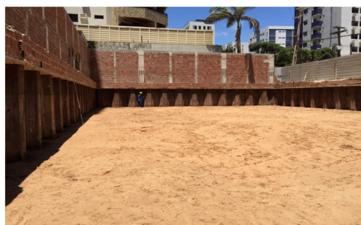
Figura 10. Contenção – Edf. CASO 2
