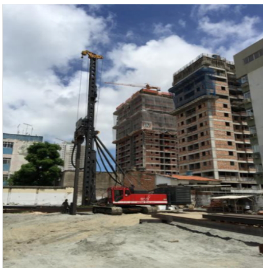
Figura 03. Execução – Edf. CASO 1.
