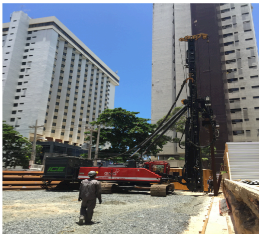
Figura 15. Execução – Edf. CASO 2.
