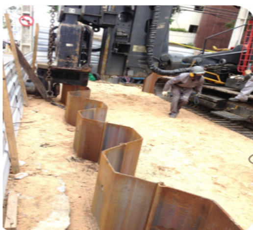
Figura 07. Execução – Edf. CASO 2.
